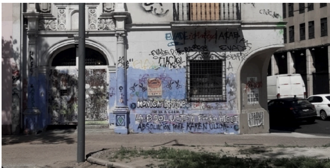
Figura 4. Fotografía propia. Fachada Merced hacia el Parque Forestal. Septiembre 2020.
