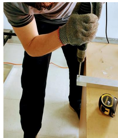
Figura 6: Perforación de perfiles
