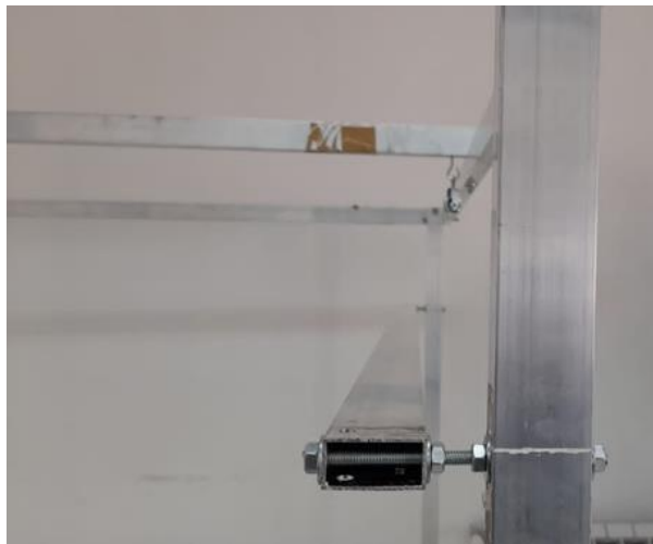
Figura 9: Colocación de perfil lateral
