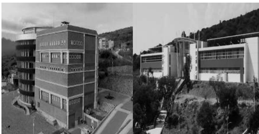
Imagen 1. Fotografía izquierda, Edificio Central. Fotografía derecha, Edificio A. Archivo propio.
