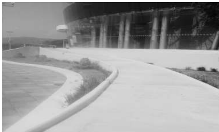
Imagen 2. Entrada principal de Edificio Central. Archivo propio.
