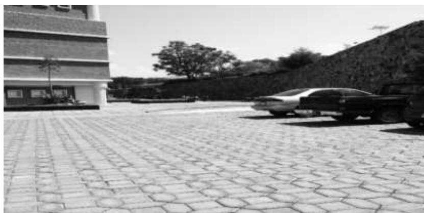
Imagen 3. Estacionamiento del Edificio Central. Archivo propio.
